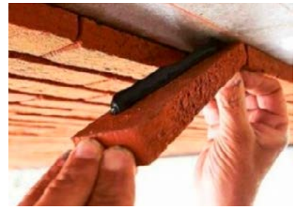
Steenstrips op cementgebonden platen aangebracht met elastische lijm
