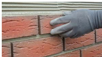
Uitvoering volgens de 'volvlak' of 'Buttering Floating' methode
