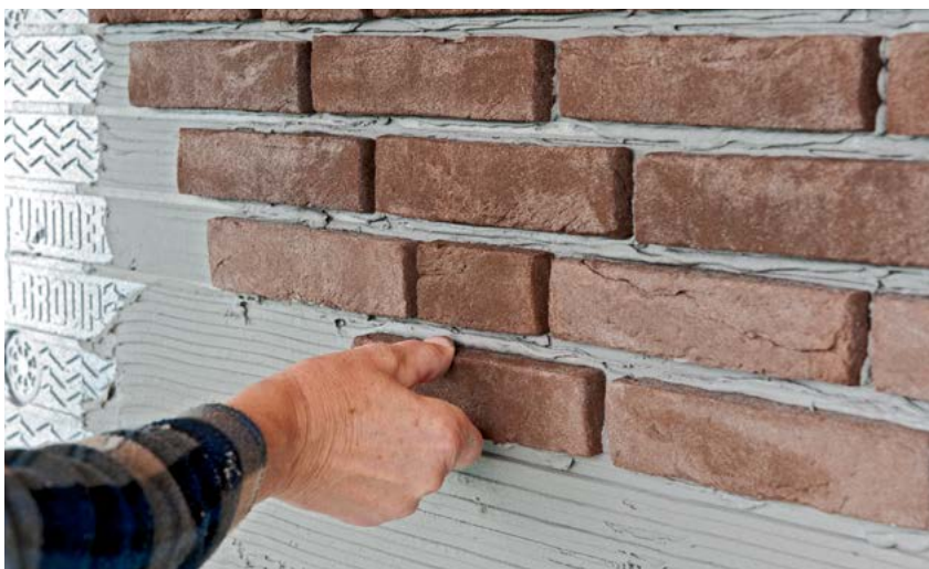
Verwerking keramische steenstrips op de bouwplaats
